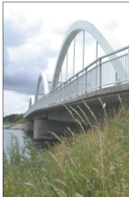
Munkholmbroen er 114 m lang og er hovedsageligt støbt på stedet med tre buer i jernbeton
